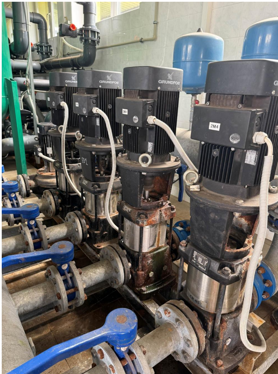
Zdjęcie 12 Istniejący zestaw hydroforowy.
